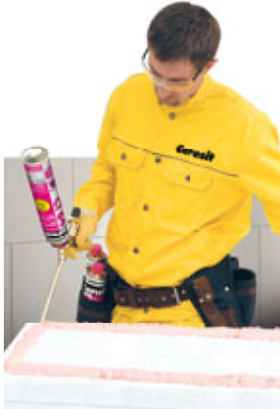
Приклеювання плит утеплювача з пінополістиролу
