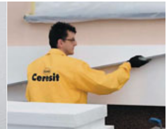
Кріплення зовнішніх підвіконь
