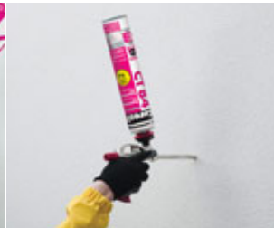
Кріплення плит з пінополістиролу
