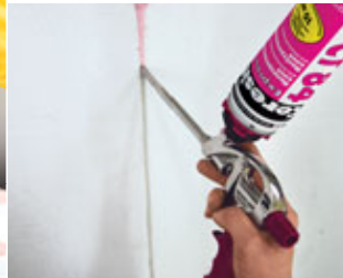
Заповнення щілин між плитами з пінополістиролу
