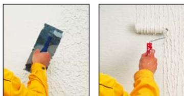
Фактуру структурной штукатурке **Ceresit CT 36** можно придать с помощью губчатого валика, терки (полутерка), лопатки, кисти или других инструментов. Возможностей достижения разных пластических эффектов – бесконечное множество. Их повторяемость зависит от умения и фантазии исполнителя.
