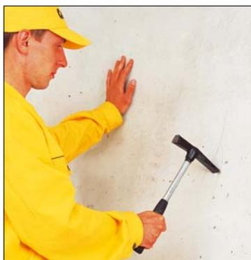
Отделочный слой, потерявший сцепление с поверхностью конструкции при подготовке к выполнению работ по устройству скрепленной теплоизоляции, удаляют при помощи дробеструйных аппаратов, а также при помощи струи воды, подаваемой под давлением до 30 МПа. При небольших объемах работ для этой цели используют кирки, зубила, скарпели и щетки.
